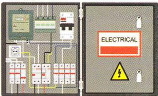
เป็นอุปกรณ์หลักที่ควบคุมการใช้ไฟฟ้า โดยสามารถสับและปลดวงจรไฟฟ้าได้ทันที ส่วนใหญ่จะใช้เป็นอุปกรณ์ตัดไฟหลักตัวเดียวหรือใช้ร่วมกับอุปกรณ์ป้องกันอื่นๆ อาทิ เครื่องตัดไฟฟ้าวรัวและเบรกเกอร์
